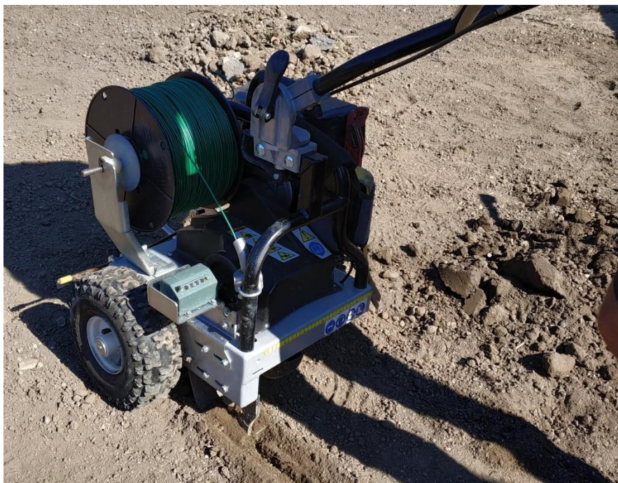
Robotfűnyíró határoló vezeték telepítése.
