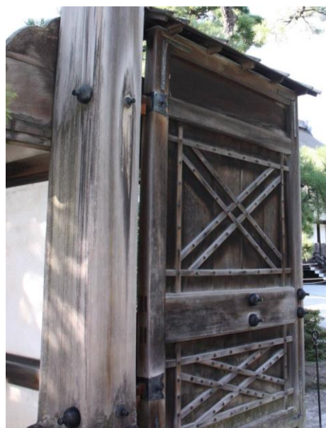
Függőleges lécezésű kapu japán zsurlóval és kerti világítással. Kapuszárny kötőcsavar esatlakoztatással.
