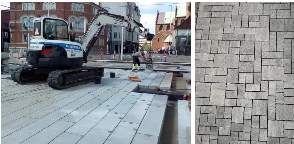
Divatos, nagyméretű burkolólapok rakása (Dánia) és kombi térkő vadkötésben rakva (Dunakeszi).
