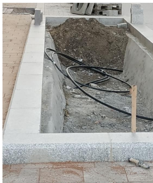
Járdasziget oldalfal betonozása a Duna korzón.
