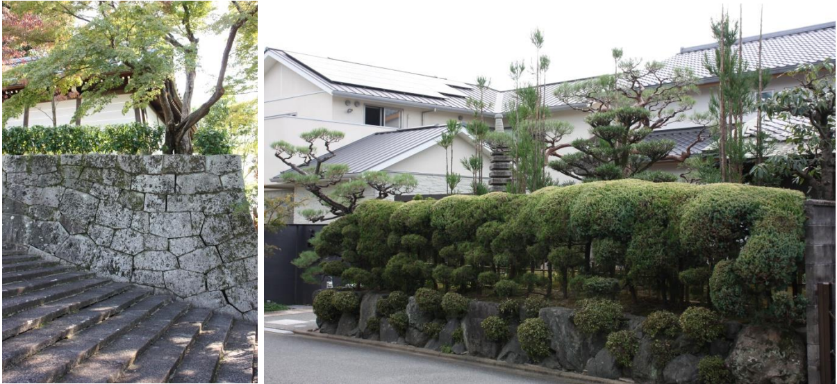
Horizontmagasság feletti támfal látványának lágyítása egy széles lépcsősor beiktatásával és támfal-sövény kombináció.
