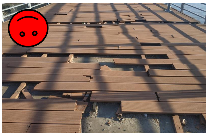
WPC burkolat rögzítése felületi csavarozással és rejtett klipsszel.
