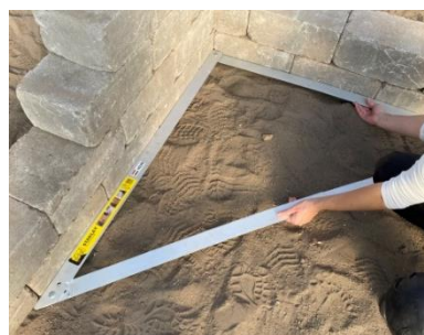
Derékszög kitűzés gyors és pontos eszközei: nagy területen keresztvonal lézer, kis szerkezeteknél összecusukható alu derékszög vonalzó.
