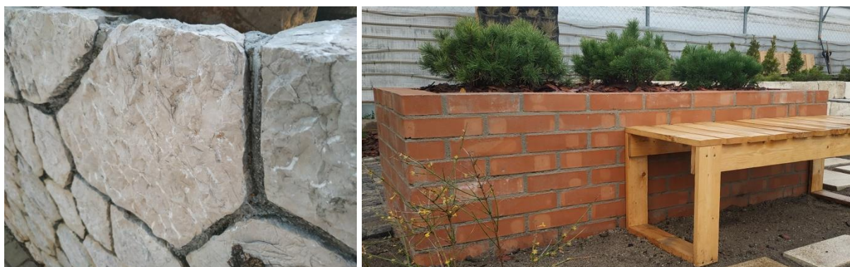
Falazóhabarcsc alkalmazása dolomit támfal és téglakiemeltágyás készítéséhez.
