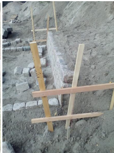
Szekrényes támfal (rézsükő) évelő beültetéssel (Budapest) és szárazon rakott támfal lécallvány segítségével (Dánia).
