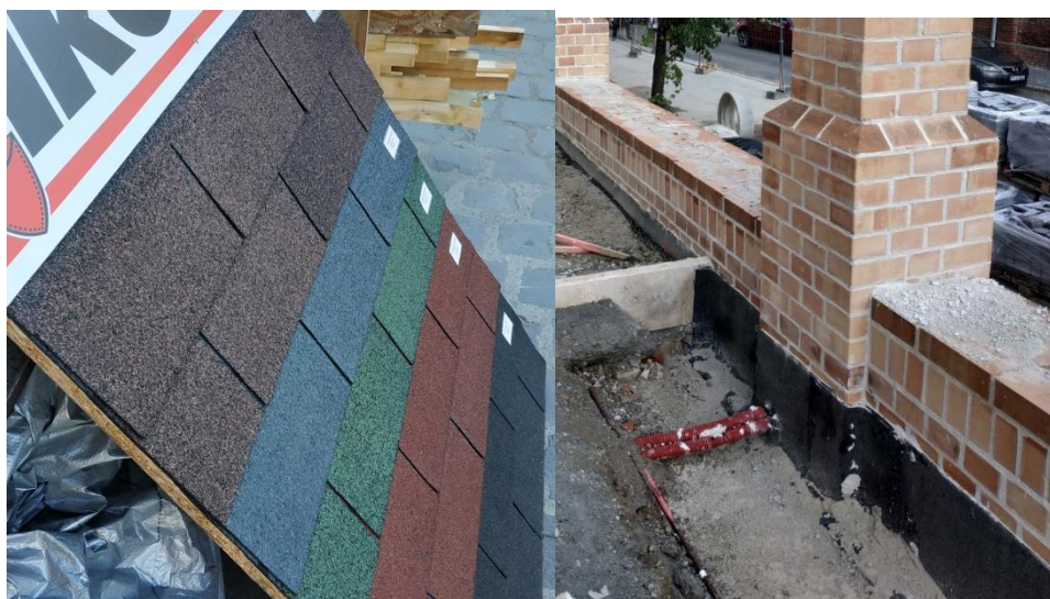
Bitumenes tetőzsindeley és téglakerítés lábázat szigetelése.
