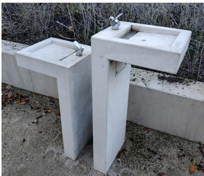
Ultra nagy szilárdságú beton (UHPC) ivókút a Széllapu Parkban.
