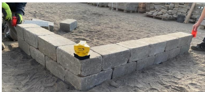
Derékszög kitűzés gyors és pontos eszközei: nagy területen keresztvonal lézer, kis szerkezeteknél összecusukható alu derékszög vonalzó.
