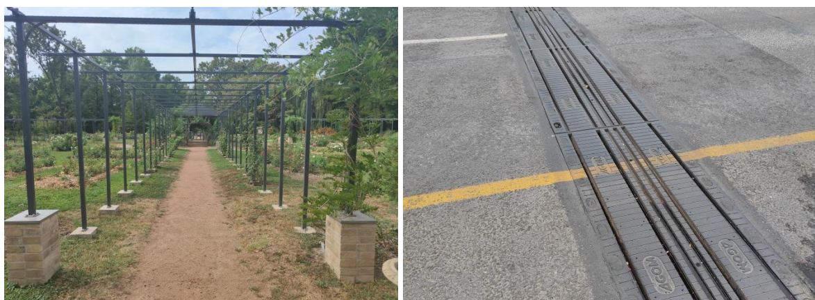
Pontalap használata pergolához (Szegei Fűvészkert) és műgumi szőnyegszerű dilatáció használata dinamikus hézag (mozgó alapok és szerkezeti elemek) esetén.
