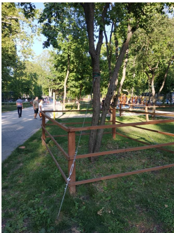
Korosfa átültetést követő horgonyzás és csurgó-védelem (Városliget). Faverebrács és favédőbrács Szombathely belvárosában.
